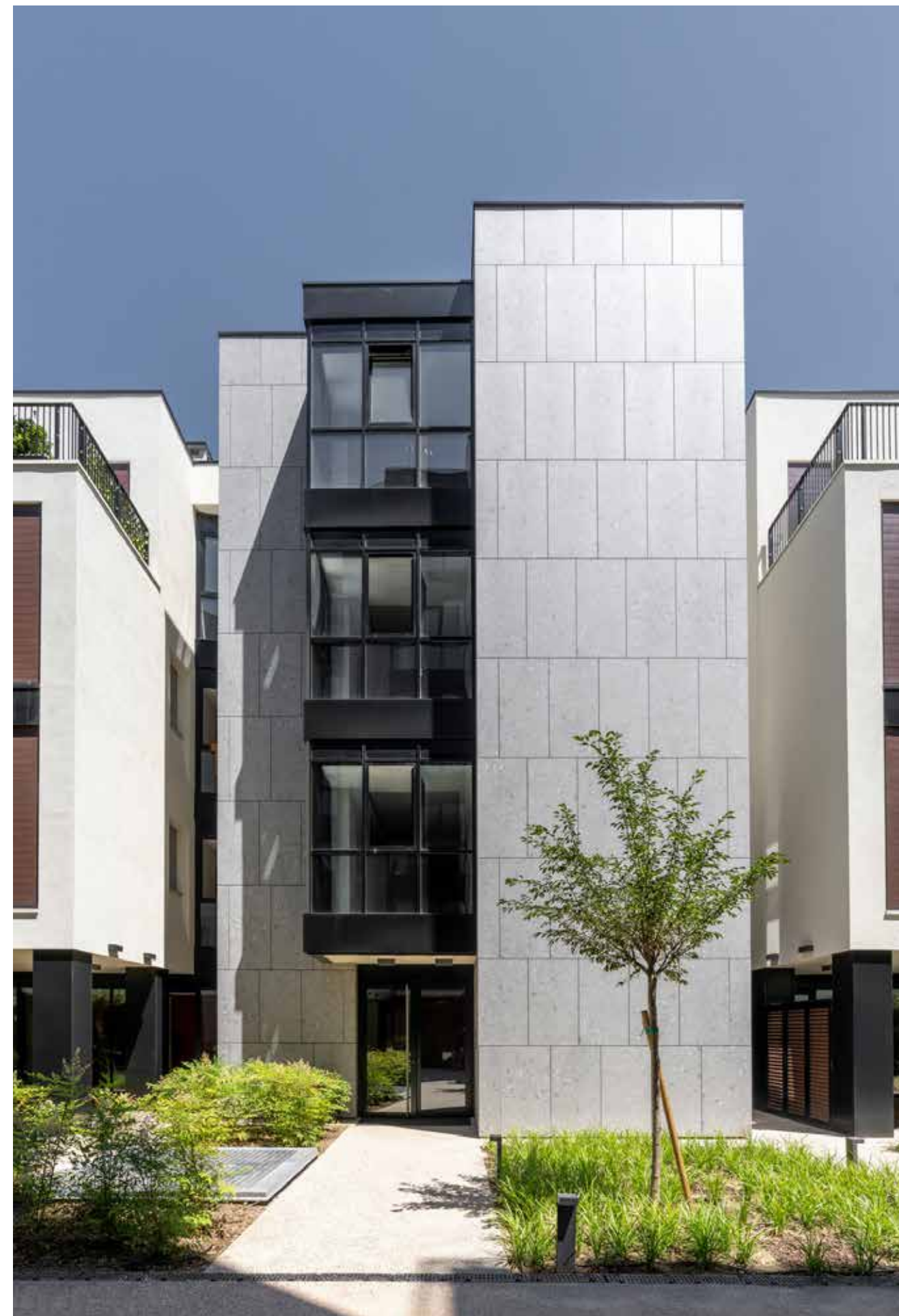
Residential Complex Sesto San Giovanni. Project: L2Architetti - Arch. Francesco Lorenzelli, Mystone Ceppo di Gre Grey 75x150 cm . Ph. Andrea Martiradonna
